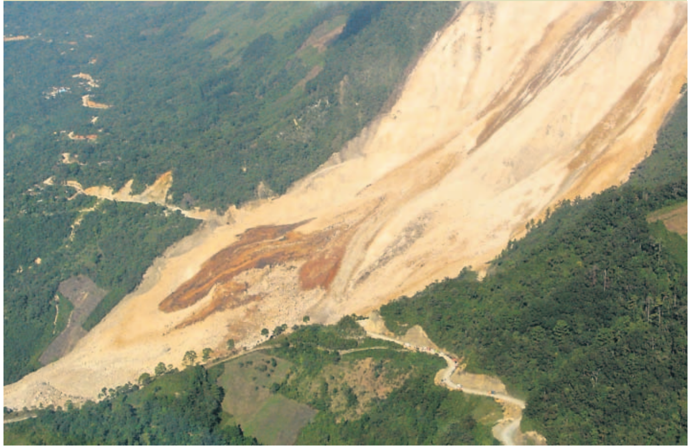
DERRUMBE. La montaña se desmoronó sobre la carretera por donde pasaban cientos de peregrinos que regresaban del mercado de un pueblo cercano.
