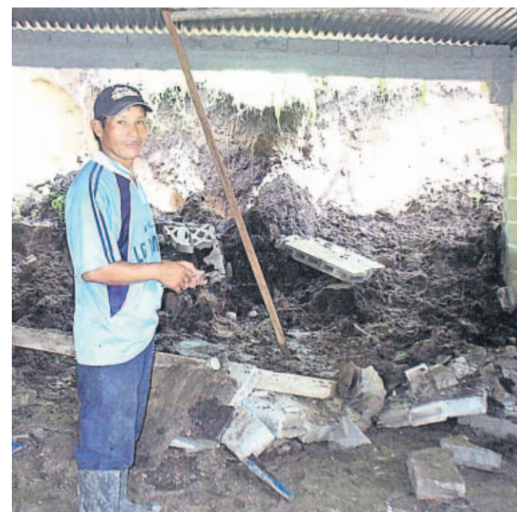
DAÑOS. Lodo y piedras cayeron sobre varias residencias.
