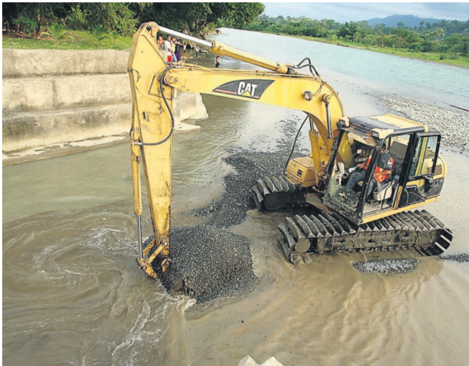
DRAGADO. Maquinaria realiza trabajos en la planta potabilizadora de Changuinola.
