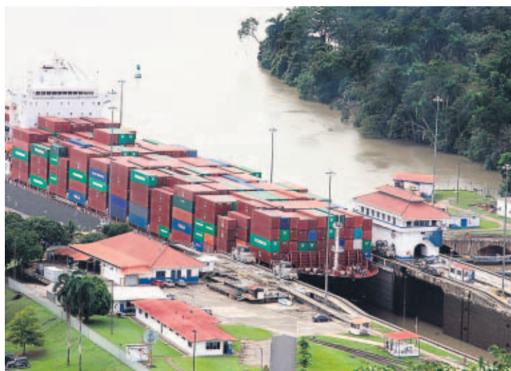
MEGAPROYECTO. Los trabajos para ampliar la vía interoceánica se extenderán hasta 2014. LA PRENSA/Carlos Lemos
