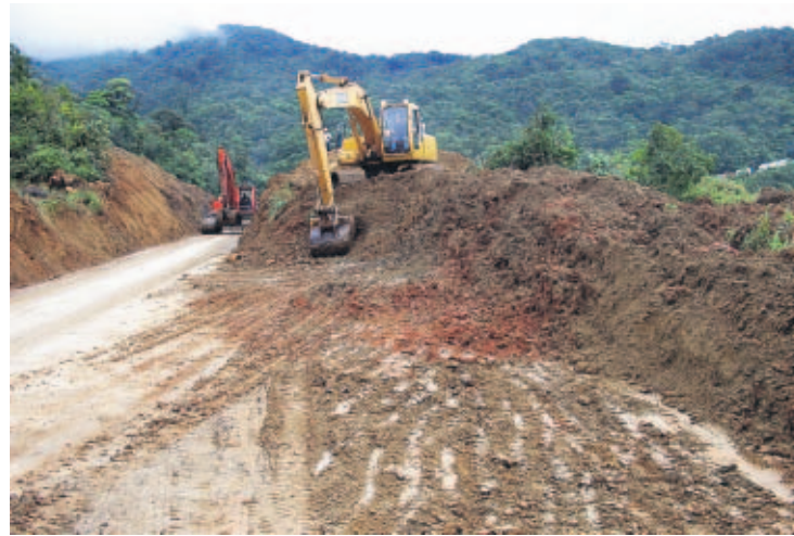
TRABAJO. Equipo pesado en trabajo de limpieza.
