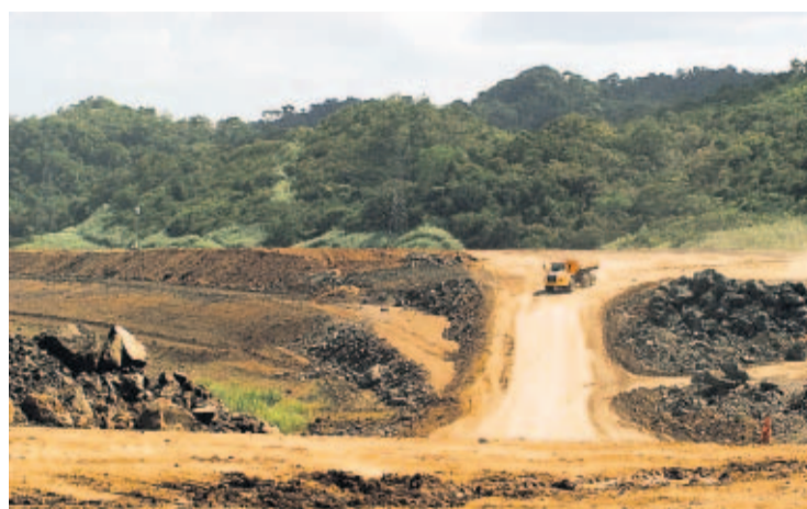
TIERRA. Lado lateral del cerro Paraíso, donde se inició la obra.
