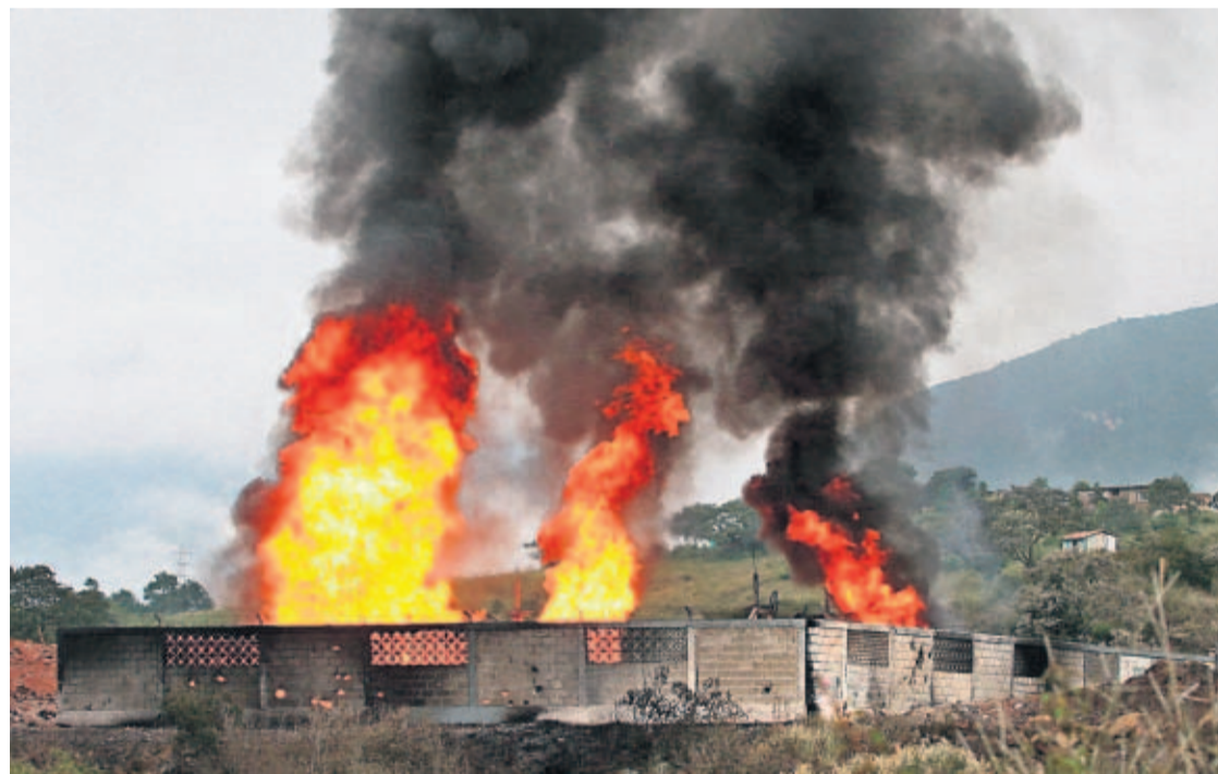
DAÑOS. Las explosiones afectaron una docena de ductos y se prevé un impacto en la distribución de gas natural en al menos 10 de los 32 estados del país, incluida la capital.
