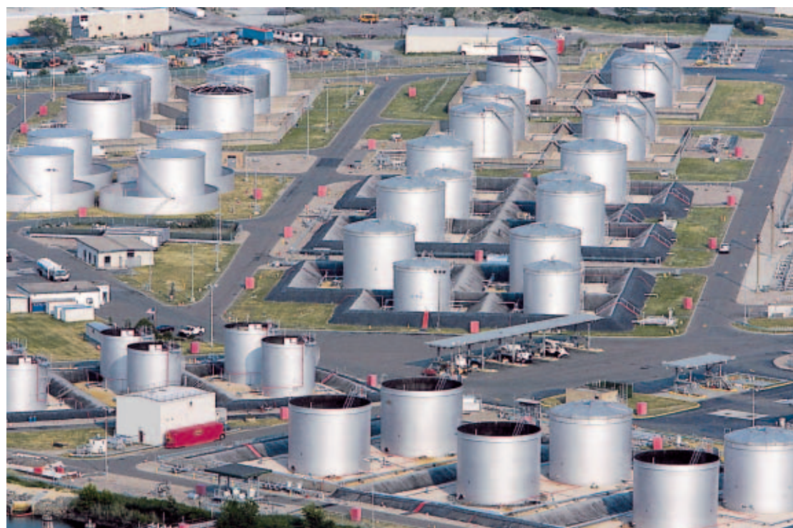
OBJETIVO. Las cañerías, de 65 kilómetros que alimentan de combustible al aeropuerto, atraviesan barrios residenciales.
