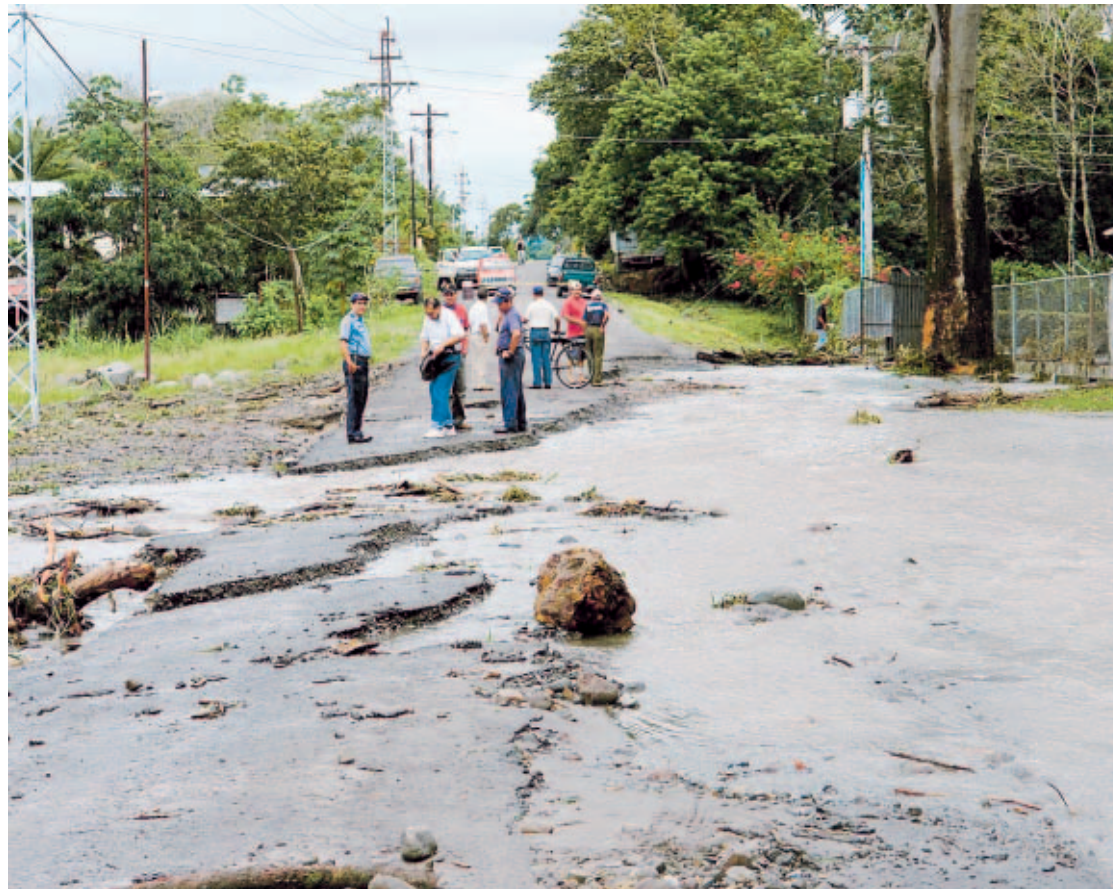
DAÑOS. El río Piedra se salió de su cauce, provocando daños en la carretera de Bugaba.
