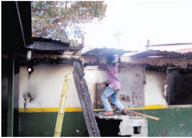
TRABAJOS. El personal de mantenimiento de la dirección regional del Minsa continúa con la demolición de las estructuras afectadas.
