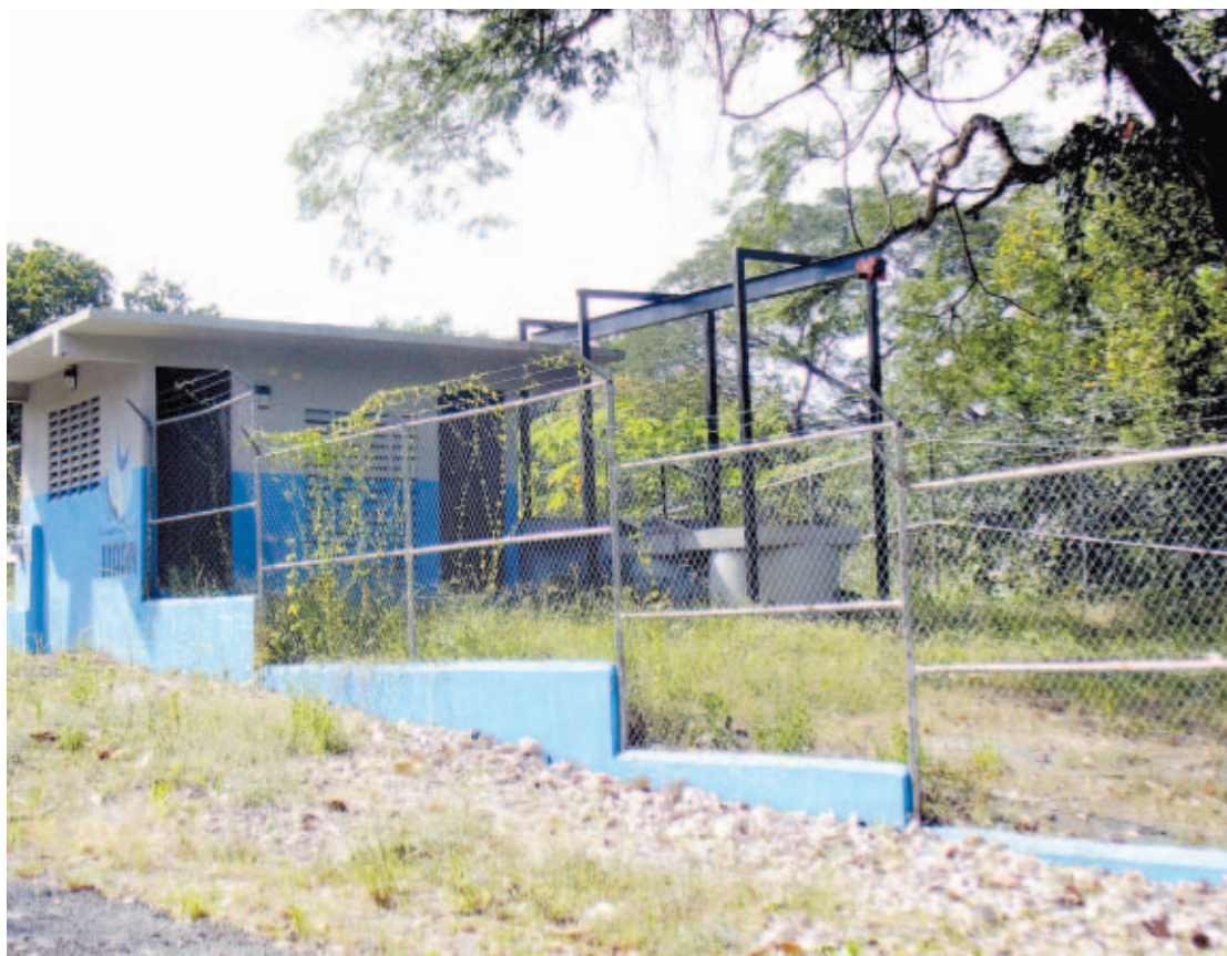
ABANDONO. La planta de bombeo que debe recoger las aguas negras está abandonada.
