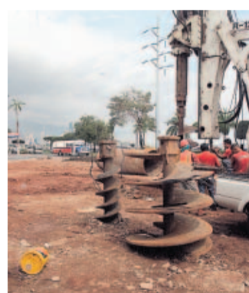
Trabajos de remoción de tierra en el sitio de la obra. LA PRENSA
