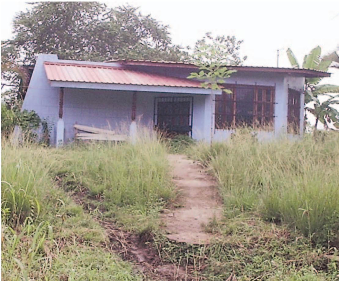
DESIDIA. La Casa de la Artesanía de San Vicente está entre las instalaciones construidas, pero que no se han inaugurado por falta de personal.
