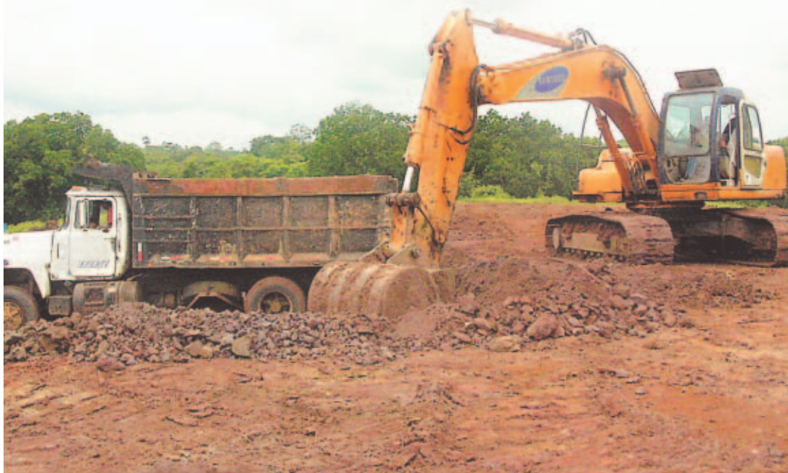
AVANCE. La maquinaria pesada ya empezó a trabajar en la limpieza del terreno en el que se edificarán las viviendas.
