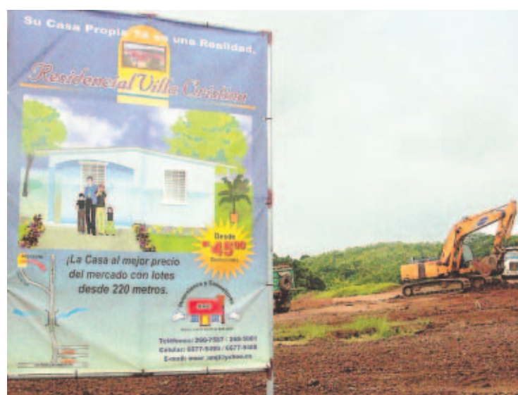
PROYECTO. La urbanización Villa Cristina constará de 115 casas con capacidad para albergar a 500 personas, en total.
