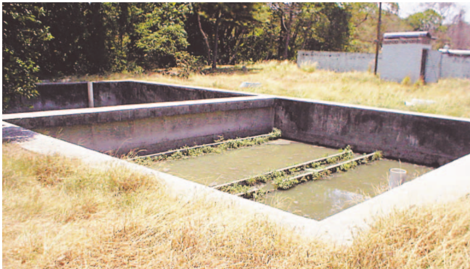
TRATAMIENTO. Las aguas negras van a tinajas de oxidación en las cuales se eliminan los sólidos y se les agrega cloro para matar algunas bacterias.
